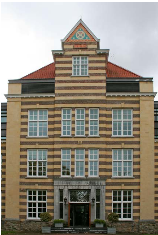
De door Jan Stuyt ontworpen Ambachtsschool in Heerlen uit 1913. Foto Léon van Loo, 2010
